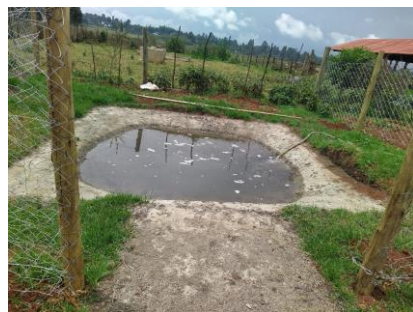
完成したため池
