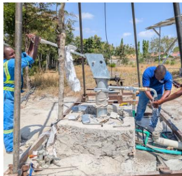
手押しでの揚水確認
